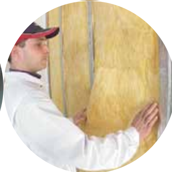
Slika 5: Važna je točna i precizna ugradnja toplinske i zvučne izolacije.
