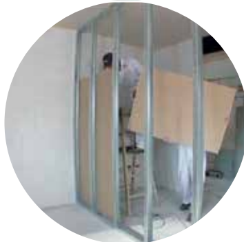
Slika 2: Postavite prvi sloj gips-kartonskih ploča.
