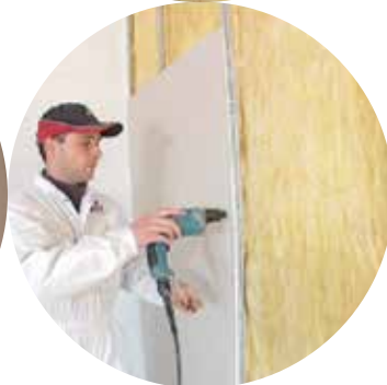
Slika 6: Zid završite oblogom od gips-kartonske ploče.
