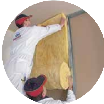
Slika 3: Postavite izolaciju u jednom komadu.
