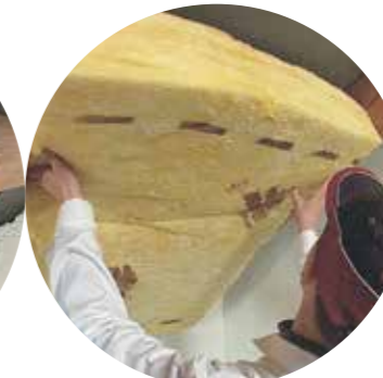
Slika 5: Izolaciju postavite između rogova – gređa.
