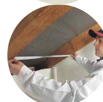
Slika 3: Dimenziji dodajte 1 do 2 cm više od izmjerene širine svijetlog otvora među rogovima – gređama
