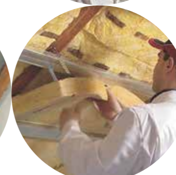
Slika 6: Ispod metalnog C-profila postavite drugi sloj izolacije.
