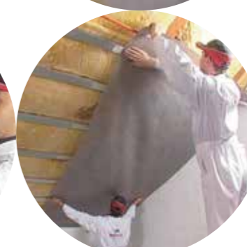
Slika 7: Na C-profil obostrano ljepljivom trakom pričvrstite parnu zapreku.
