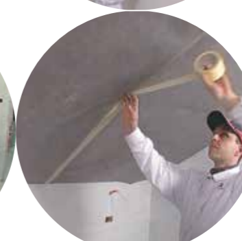
Slika 8: Sve spojeve, proboje i priključke morate dobro zalijepiti.
