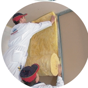
Slika 3: Postavite izolaciju u jednom komadu.
