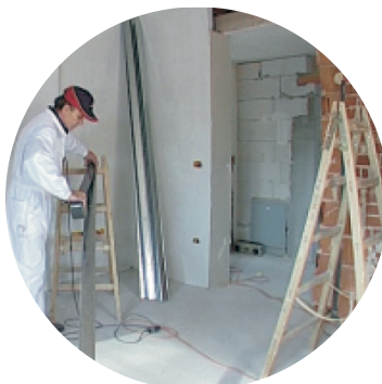
Slika 1: Nalijepite brtveću – dilatacijsku traku
