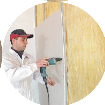
Slika 6: Zid završite oblogom od gips-kartonske ploče.
