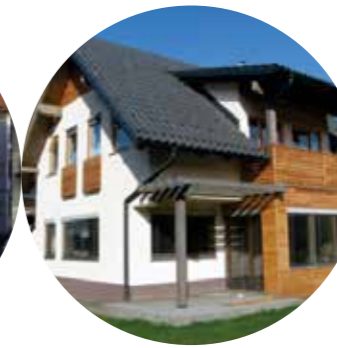
Slika prikazuje objekt kojeg namjeravamo snimiti termovizijskom kamerom.
