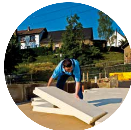
Polaganje izolacije od ekstrudiranog polistirena URSA XPS na tamponski sloj
