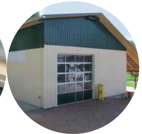
Komercijalna gradnja na podnoj ploči s pasivnim temeljima
