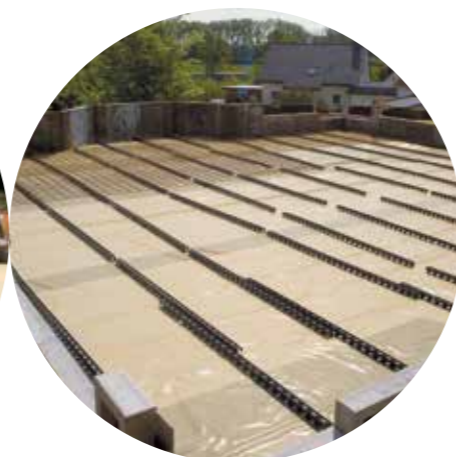
Položena izolacija od ekstrudiranog polistirena URSA XPS kao srednjeg sloja i distancerima za armaturnu mrežu
