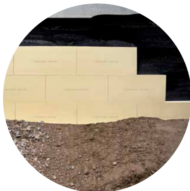
URSA XPS – izolacija zida u zemlji s vanjske strane
