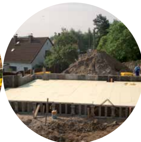
Pravilno postavljena izolacija od ekstrudiranog polistirena URSA XPS za obiteljsku kuću
