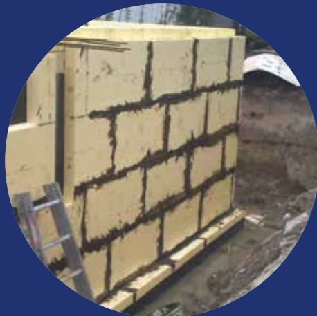
Obrada izolacije URSA XPS u slučaju vode koja teče pod pritiskom
