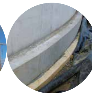
Temeljna ploča izolirana proizvodom URSA XPS N-V-L
