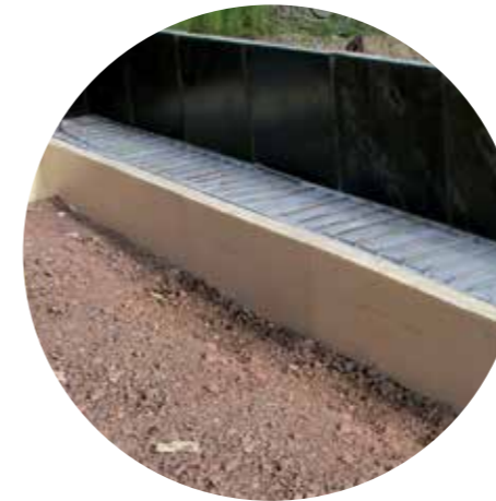
URSA XPS N-III-L debljine 160 mm ispod podne ploče s pasivnim temeljima
