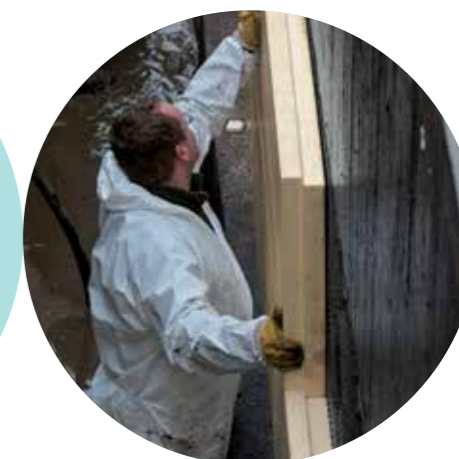
Postavljanje izolacijskih ploča URSA XPS na vanjskom zidu podruma
