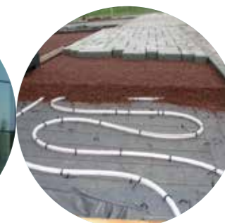
Parkirne površine za stranke tvrtke Pietsch Haustechnik GmbH. Izolacija parkirnih površina proizvodom URSA XPS N-VII-L
